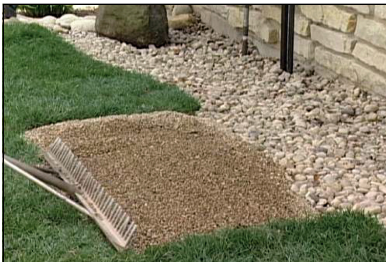
Рис. 3-3. Место установки с уплотненным гравием.
