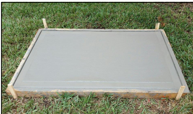
Рис. 3-4. Место установки с бетонной подушкой.
